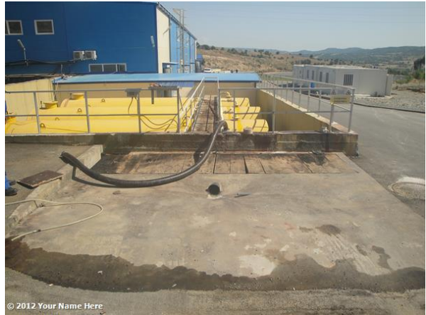
Слика Танквана за резервоари на сулфурна киселина (лево) и пристапна рампа за достава на киселина (десно)
