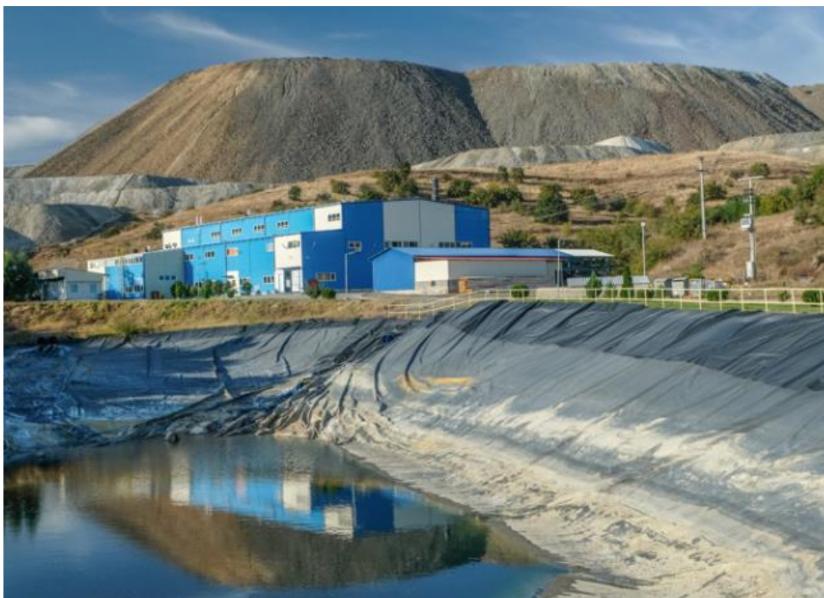
Слика Инсталација (технолошки комплекс) за лужење на бакар, произведен објект
