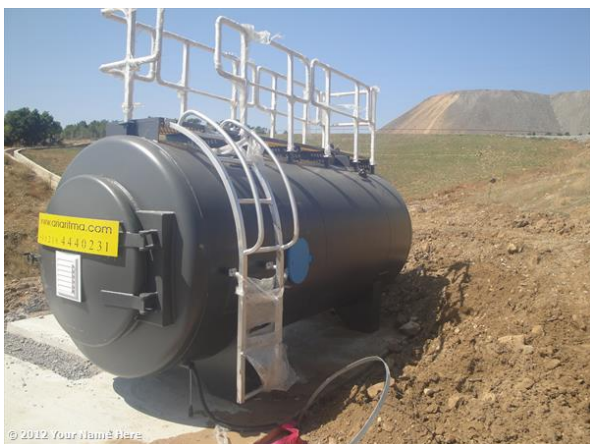
Слика Пречистителна станица за комунални отпадни води
