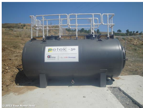
Слика Пречистителна станица за комунални отпадни води
