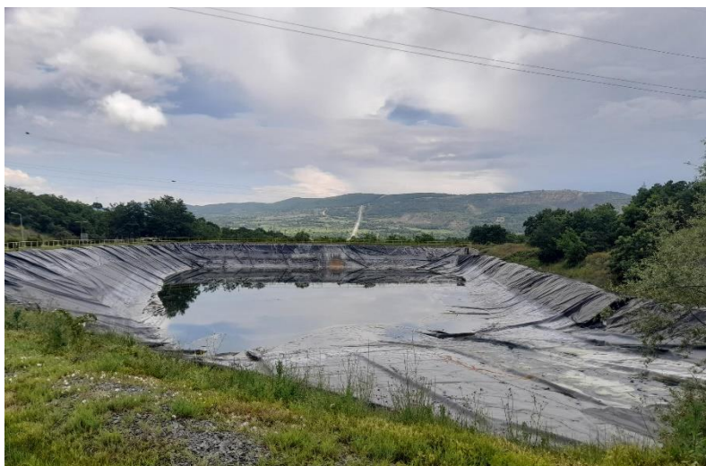
Слика Хидроизолација на собирно езеро
