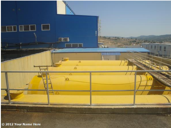
Слика Танквана за резервоари на сулфурна киселина (лево) и пристапна рампа за достава на киселина (десно)
