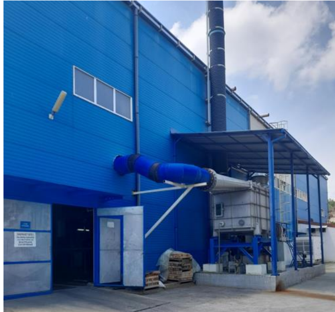
Слика Излез од вентилација на северна страна на објект (мокар скрубер, АЕ1)
